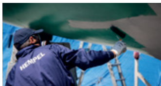
Auftragen von Antifouling auf Primer oder Haftgrund
