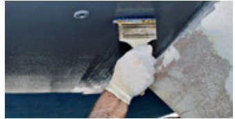
Hempel's High Protect II mit einem Pinsel in entgegengesetzter Richtung verschlichten
