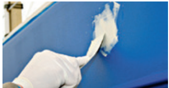
Einzelne Stellen mit Spachtelmesser bearbeiten
