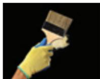
1. Tragen Sie 1 Schicht Hempel's Silic One (Decklack) auf die beschädigte Stelle auf
