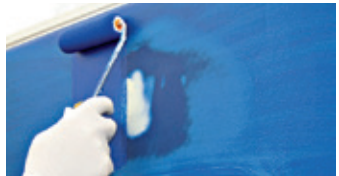
Primer auf einzelne Stellen auftragen
